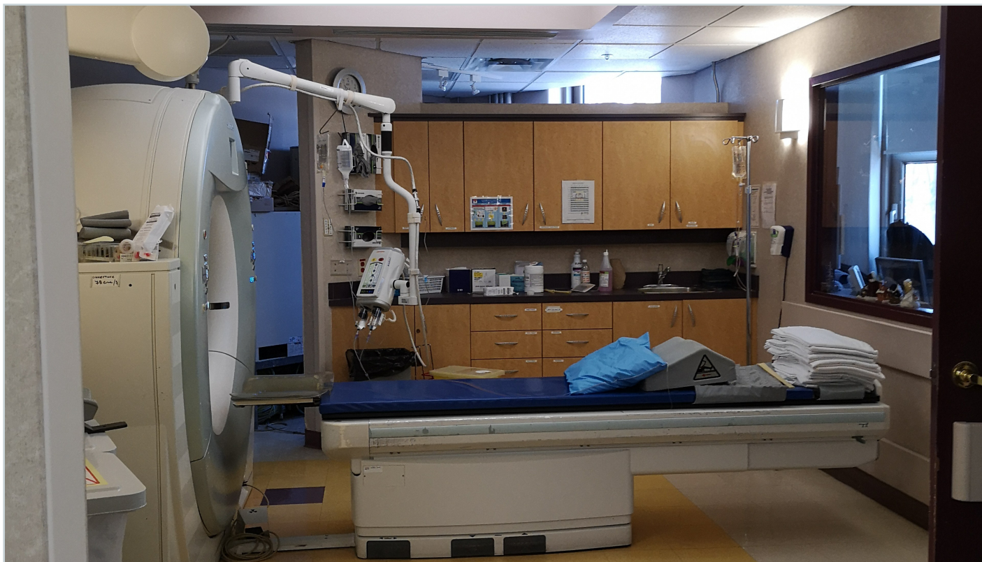
1. Sala de tomografía computarizada: infraestructura clínica diseñada para integrar equipamiento de diagnóstico por imágenes, circulación segura y áreas de apoyo técnico.
